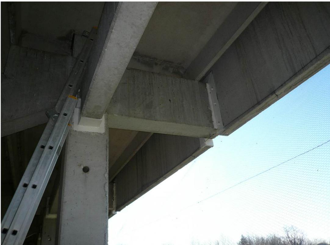
Foto n. 4) – Interventi su parti in calcestruzzo armato, e nei collegamenti in acciaio tra trave e pannelli
