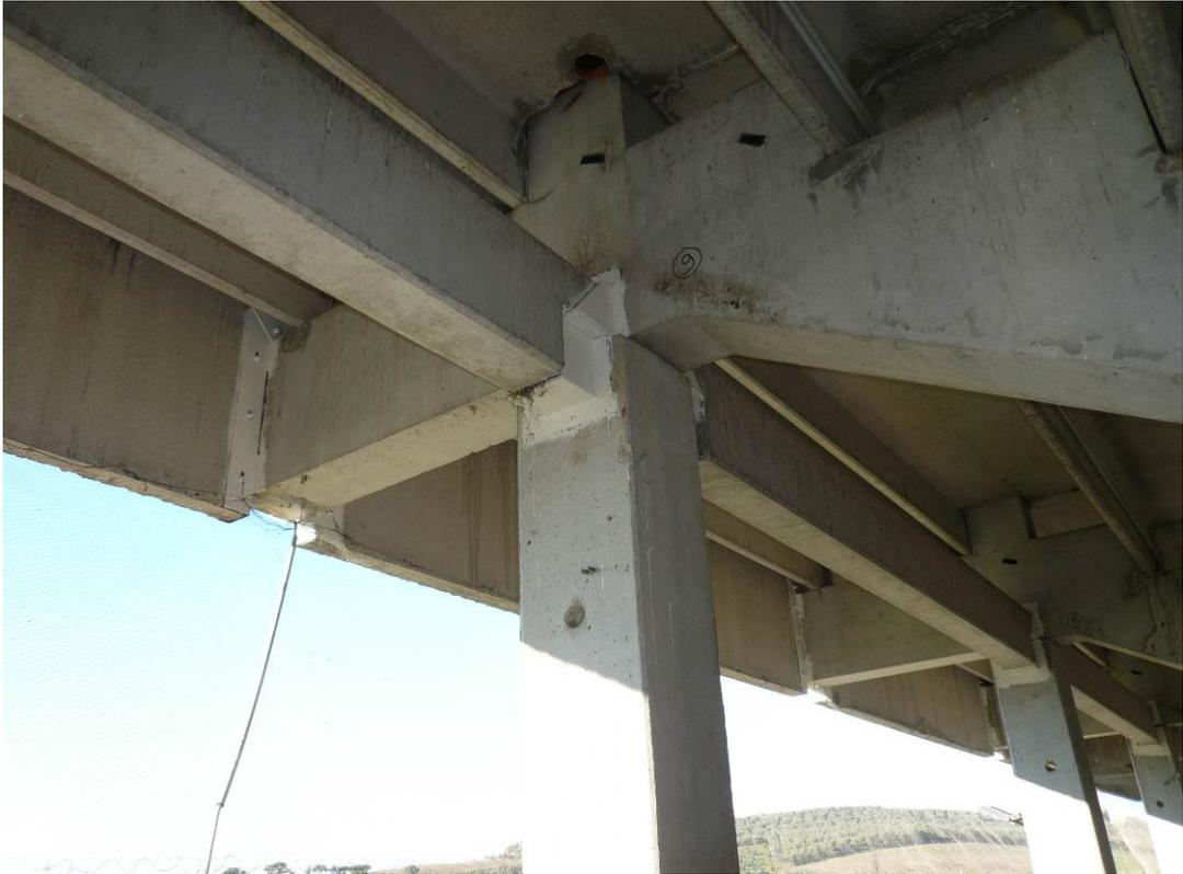
Foto n. 9) - Interventi su parti in calcestruzzo armato, e nei collegamenti in acciaio tra trave e pannelli
