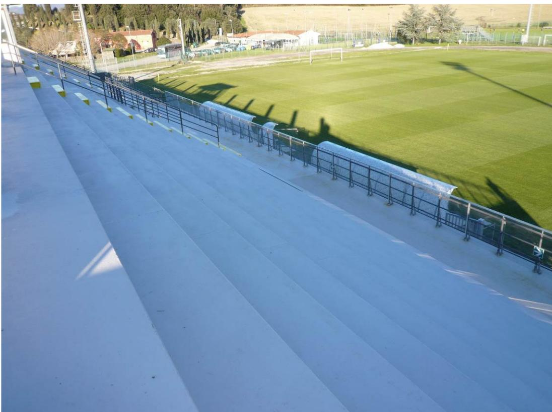
Foto n. 14) - Interventi su parti in c.a. e impermeabilizzazione gradoni, parapetti adeguati parte agibile
