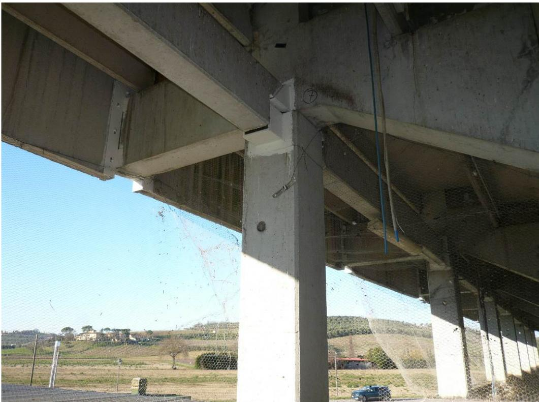
Foto n. 6) - Interventi su parti in calcestruzzo armato, e nei collegamenti in acciaio tra trave e pannelli
