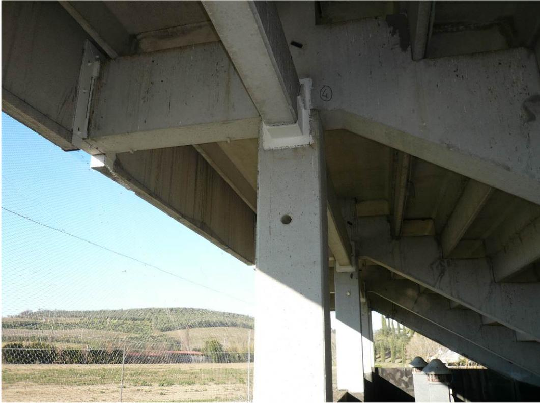
Foto n. 5) – Interventi su parti in calcestruzzo armato, e nei collegamenti in acciaio tra trave e pannelli
