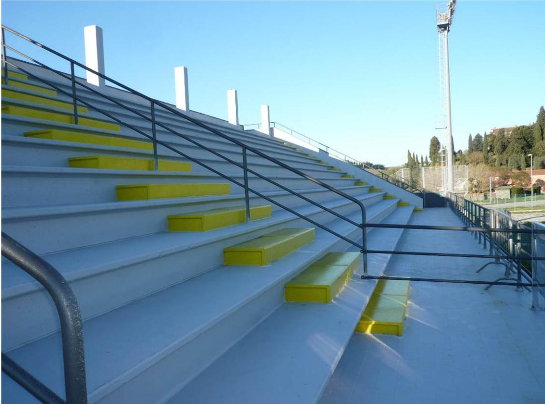
Foto n. 13) - Interventi su parti in c.a. e impermeabilizzazione gradoni, sbarramento parte non agibile
