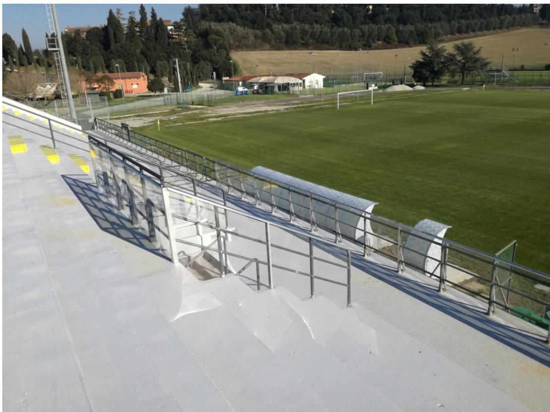
Foto n. 15) - Interventi su parti in c.a. e impermeabilizzazione gradoni, parapetti adeguati parte agibile
