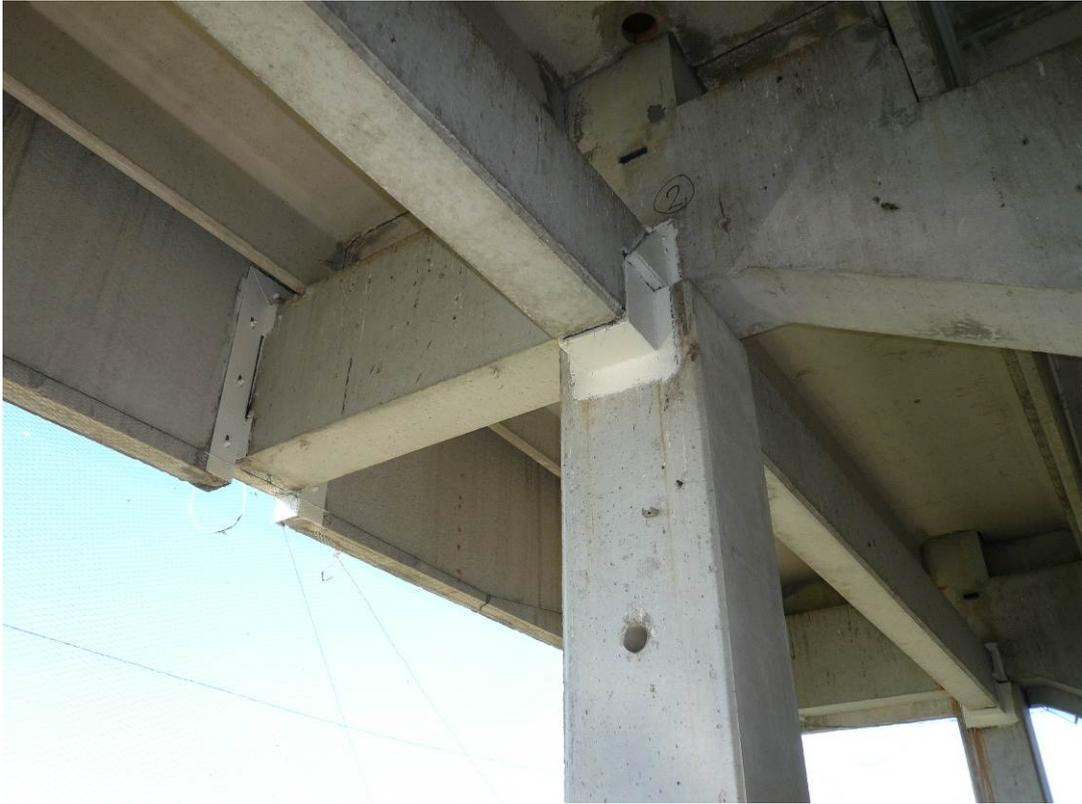
Foto n. 3) – Interventi su parti in calcestruzzo armato, e nei collegamenti in acciaio tra trave e pannelli
