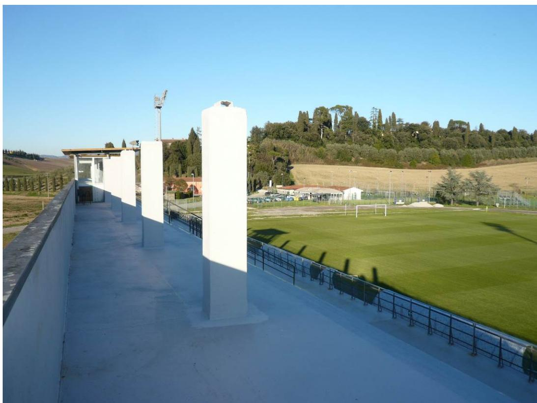
Foto n. 12) - Interventi sui pilastri e altre parti in calcestruzzo armato, impermeabilizzazione gradoni
