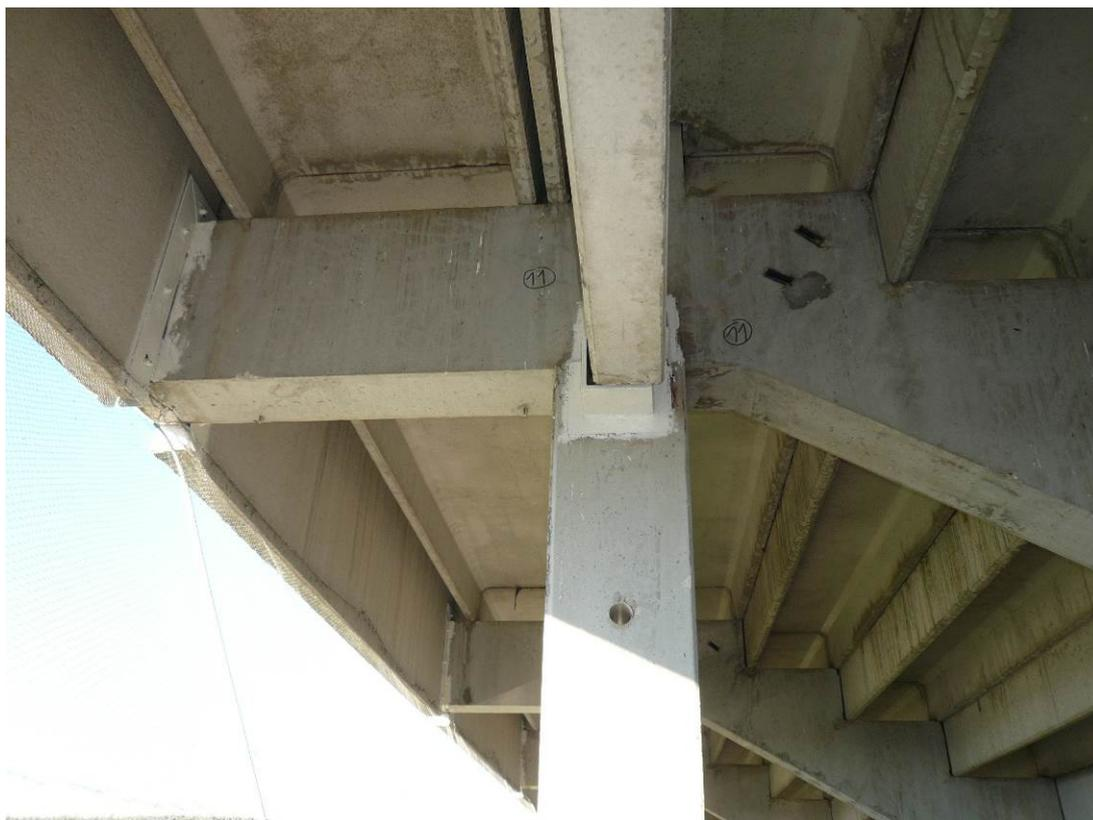
Foto n. 11) - Interventi su parti in calcestruzzo armato, e nei collegamenti in acciaio tra trave e pannelli
