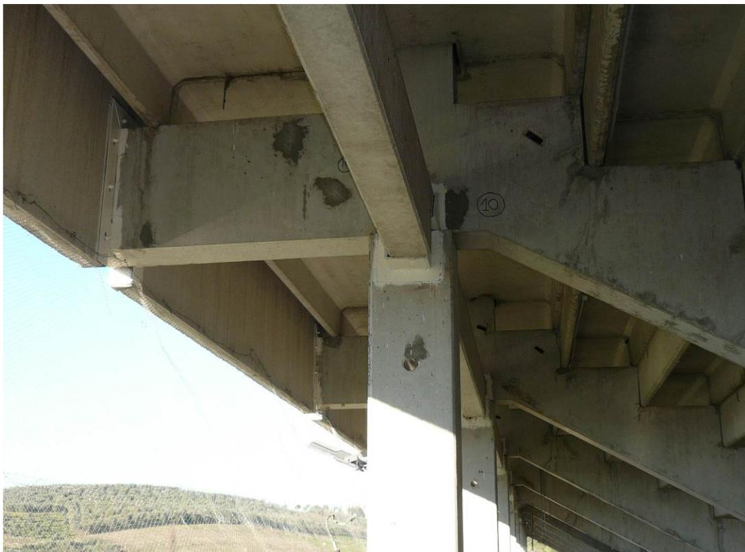
Foto n. 10) - Interventi su parti in calcestruzzo armato, e nei collegamenti in acciaio tra trave e pannelli
