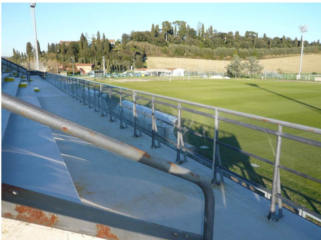
Foto n. 16) – Parapetto adeguato posto alla base della tribuna della parte agibile
